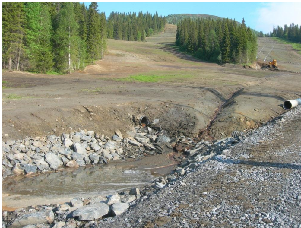
Bild 16. Sedimentationsdamm i anslutning till avskärande dike. Exempel från Åre.
